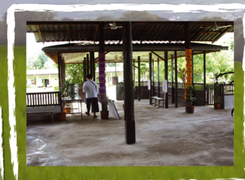
โรงเรียนมีอาคารเอนกประสงค์ที่มีพื้นที่ภายในอาคารชั่วคราวและซุชระเป็นอุปสรรคต่อการจัดกิจกรรมของโรงเรียนและชุมชน
